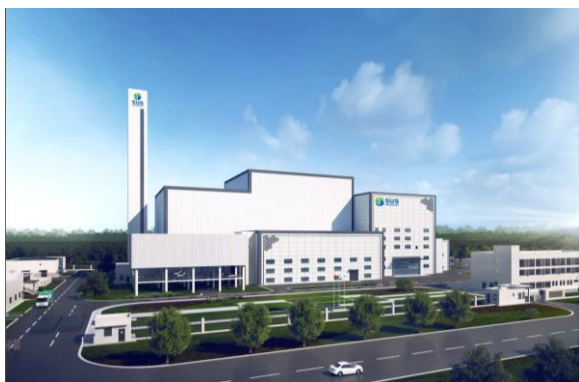
乌兹别克斯坦卡什卡达里亚生活垃圾焚烧发电项目（规模：1500吨/日）
