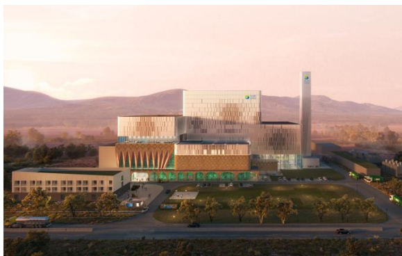
乌兹别克斯坦撒马尔罕生活垃圾焚烧发电项目（规模：1500吨/日）
