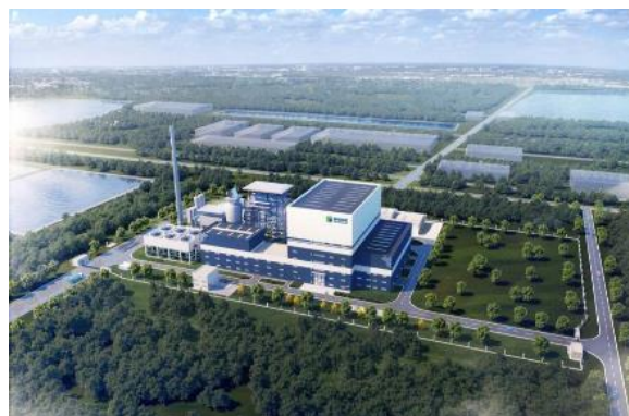
泰国暖武里生活垃圾焚烧发电项目（规模：1000吨/日）
