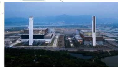
珠海项目 3,000吨/日 (一期, 二期)
